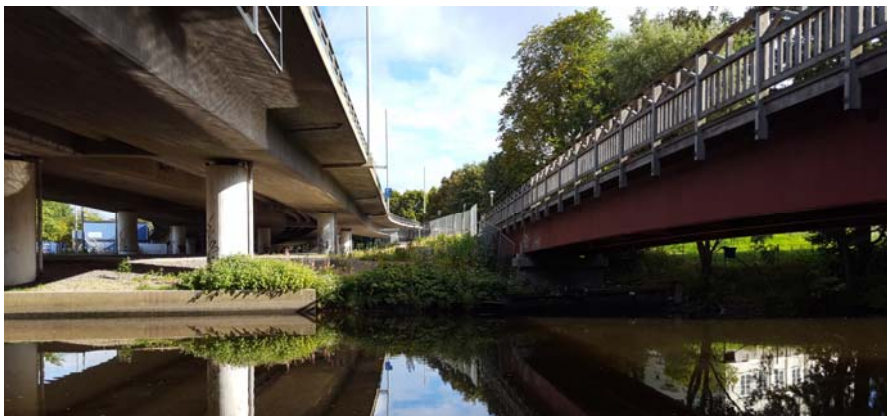
Figur 22 Befintlig bro för Gamlestadsvägen till vänster och befintlig gång- och cykelbro till höger i bild.
