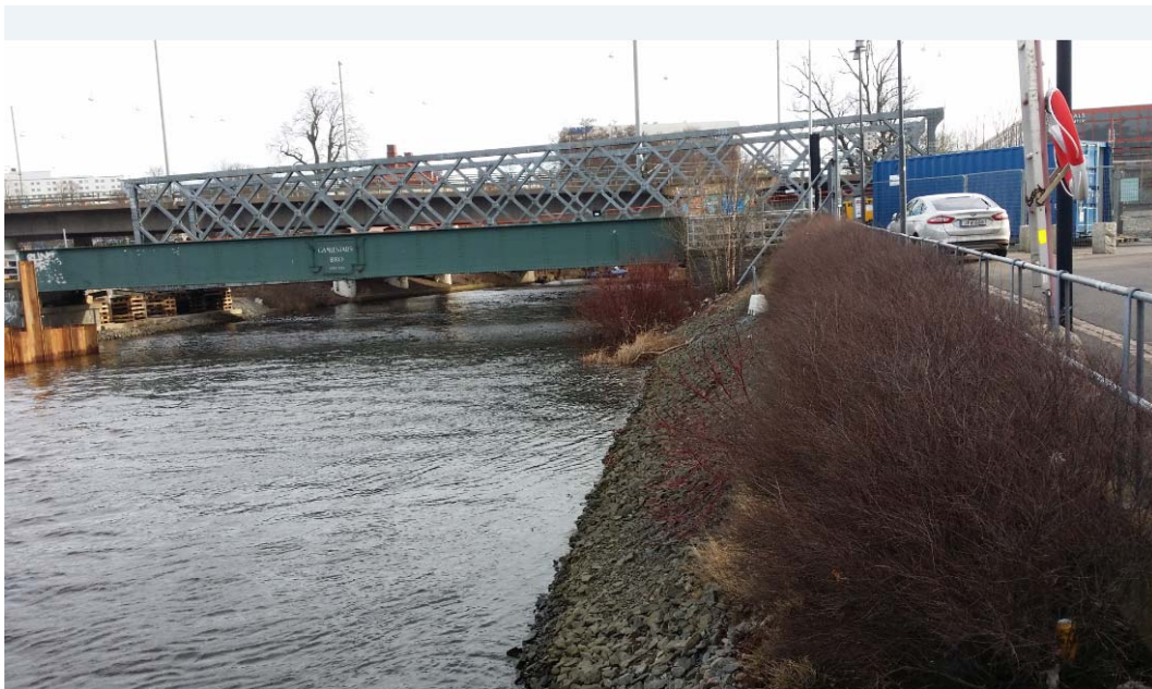
Figur 13 Befintlig L-stödmur vid Gamlestadens fabriker.
