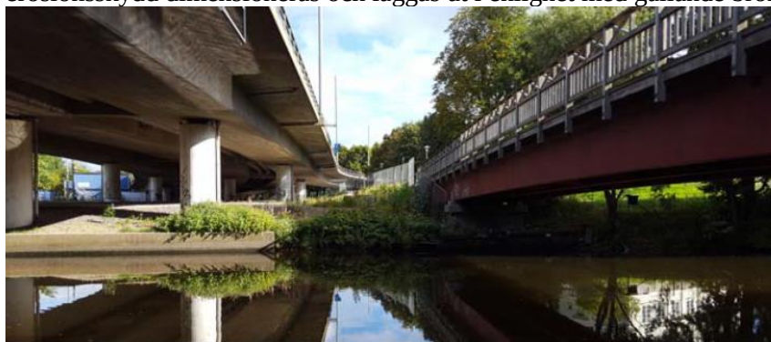
Foto 1. Befintlig vägbros norra landfäste
