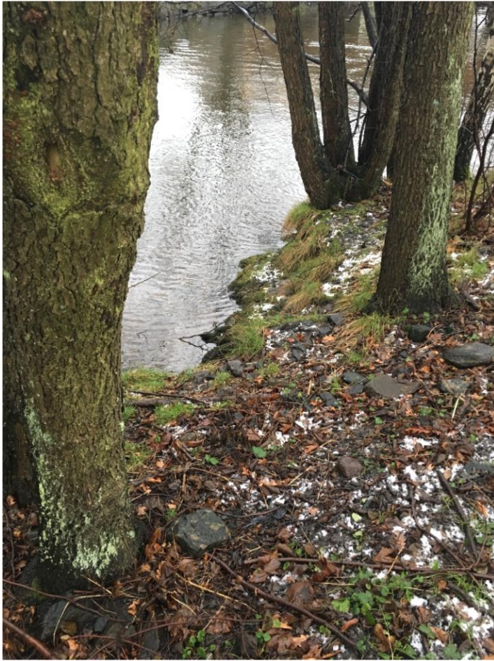
Foto 2. Befintlig erosionsskydd öster om befintlig vägbro norra sida
