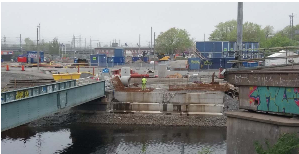
Figur 17 Befintlig gång- och cykelbro, till vänster i figuren. Landfäste till tillfälliga spårvägsbroar, centrerat i bilden. Till höger i bilden syns befintlig bro för Gamlestadsvägen.
